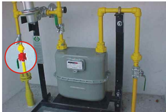
Toda estação possui uma válvula vermelha. Ela é a válvula principal que fecha todo o fornecimento de gás no seu estabelecimento.
